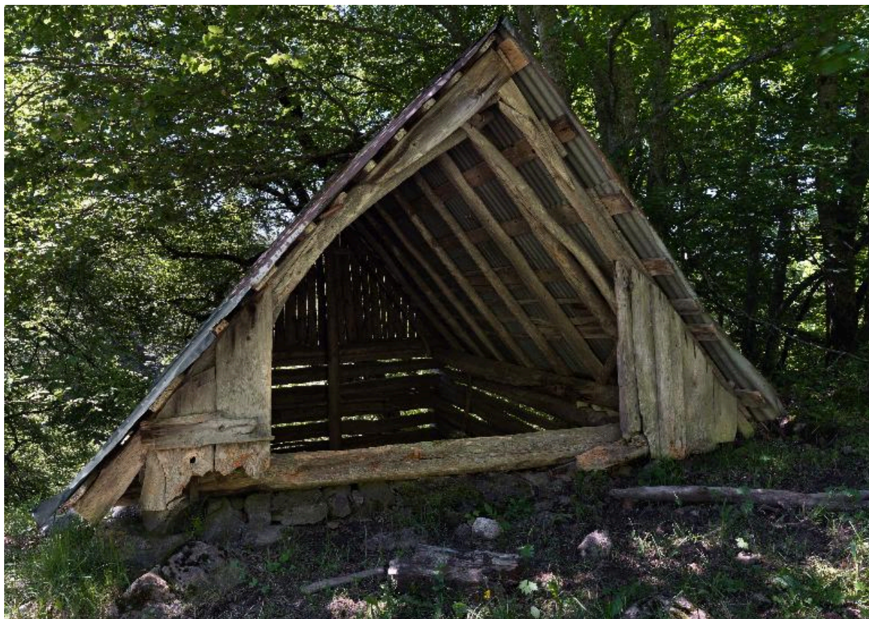
Vue d'ensemble côté amont.
