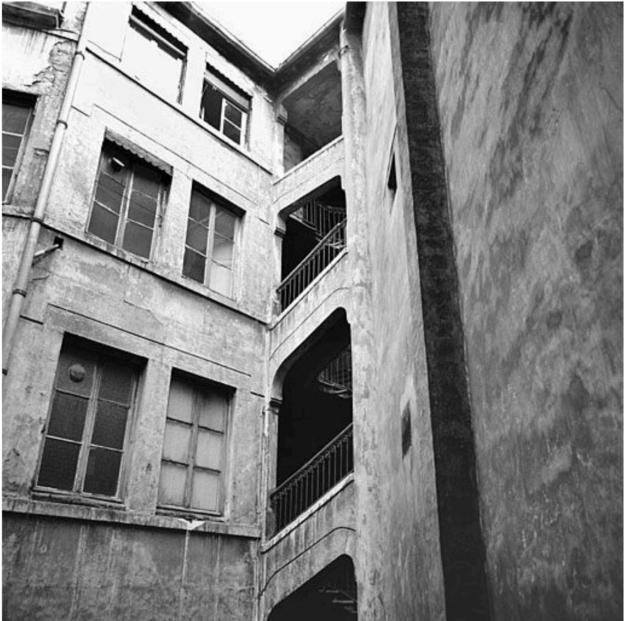
Vue partielle des élévations sur cour : deuxième et troisième étages carrés, étage d'attique
