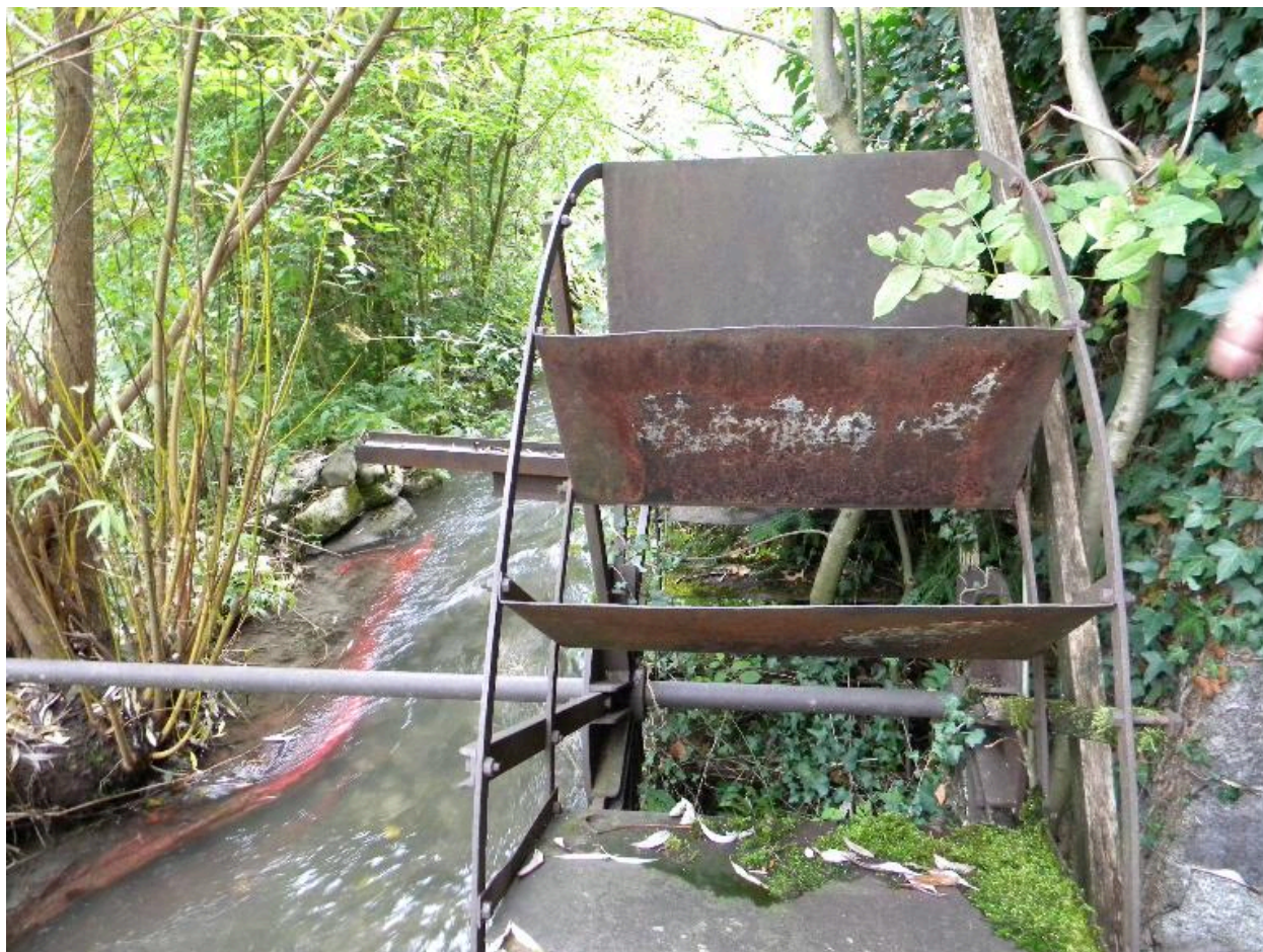
Vue de la roue hydraulique sur le bief.
