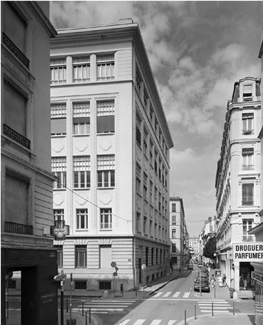
Façade sur la rue Henri-IV et retour sur la rue Franklin
