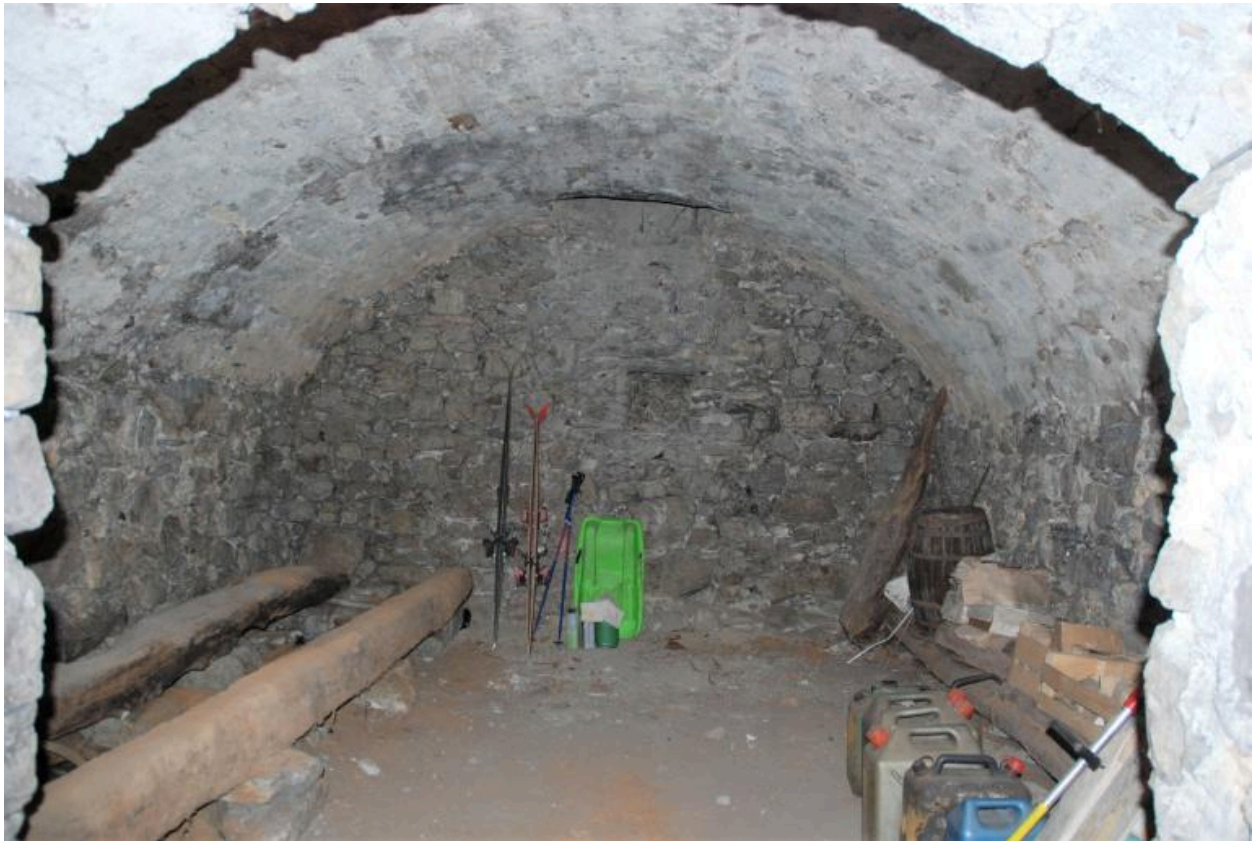
Sous-sol, deuxième cave voûtée, vue d'ensemble vers l'est.
