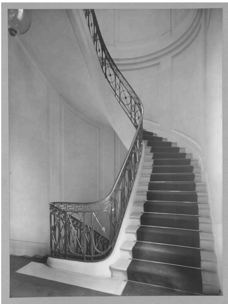
Vue de l'escalier desservant l'appartement de fonction du directeur (Banque de France, PHAR, non coté, photographie).
