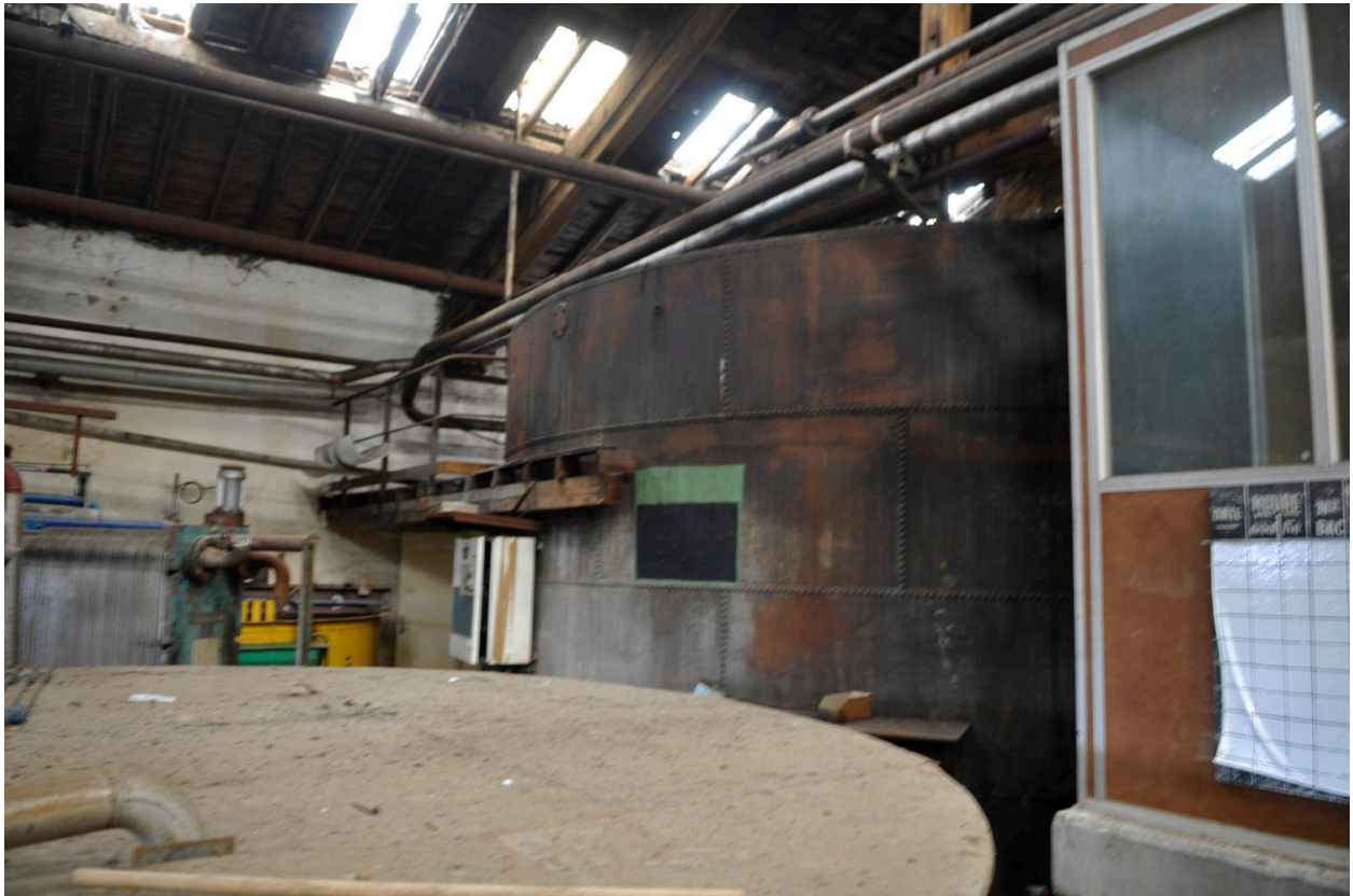
Vue de l'intérieur des ateliers
