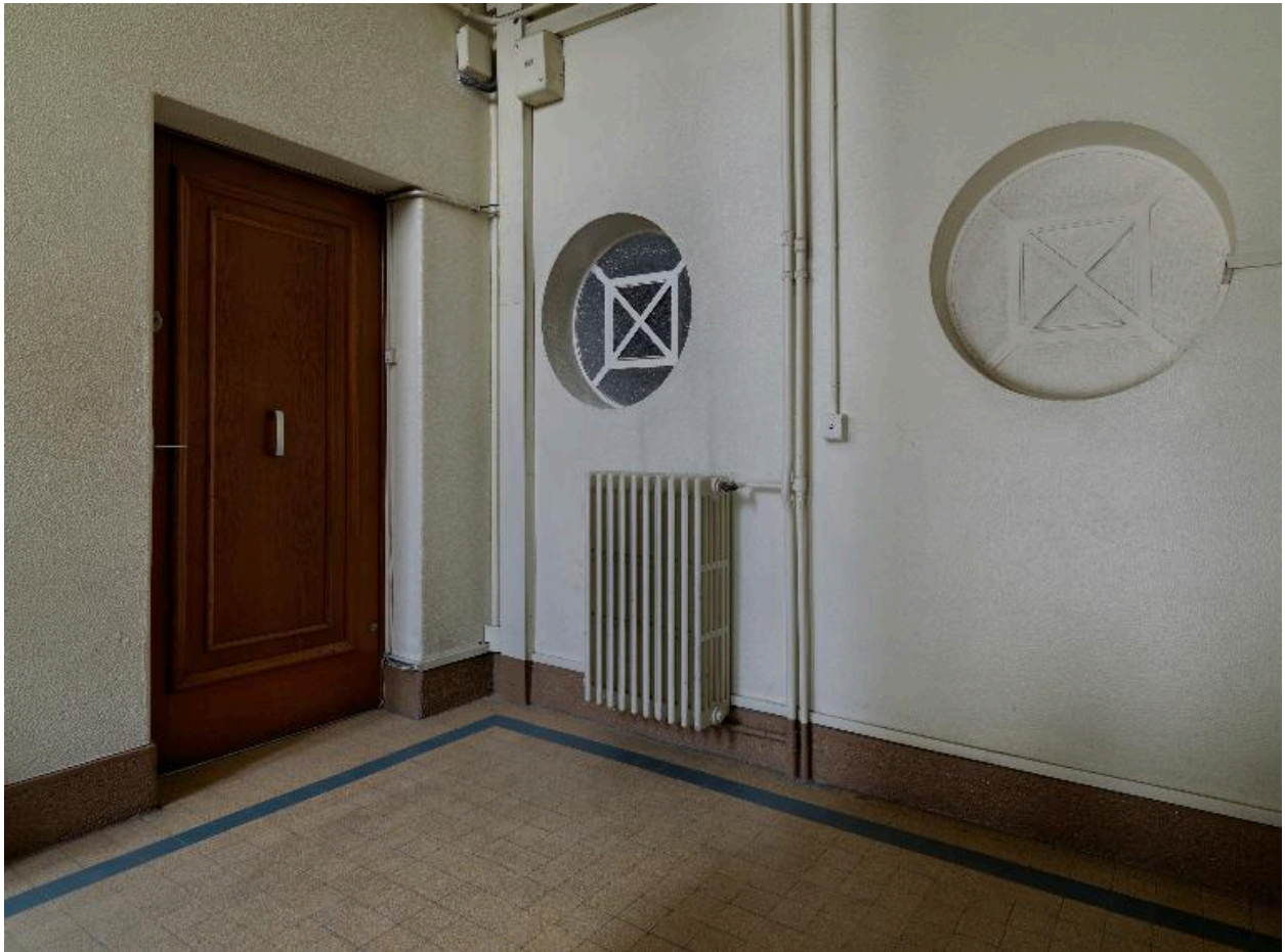
Pavillon est, palier du rez-de-chaussée (logement de fonction)
