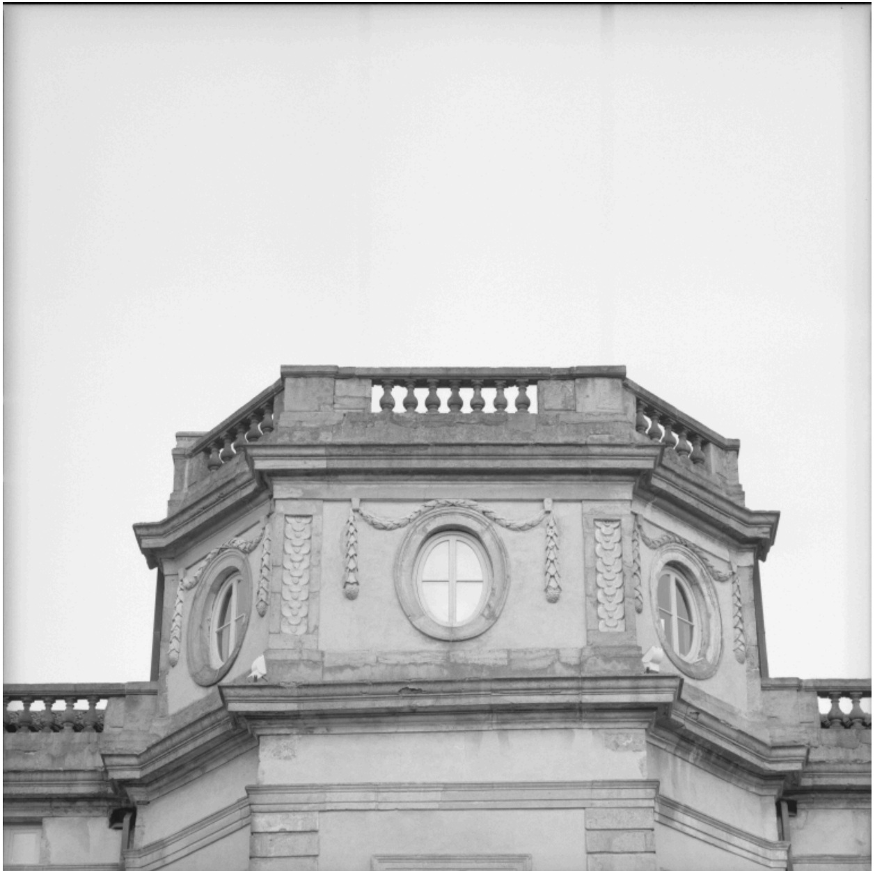
Détail de la façade sur jardin : partie supérieure de l'avant-corps central.
