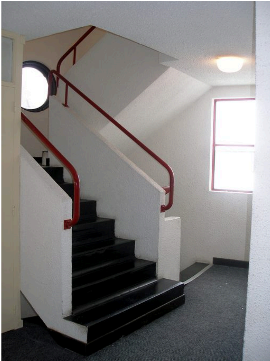
L'escalier, éclairé en second jour par la cage vitrée de l'ascenseur
