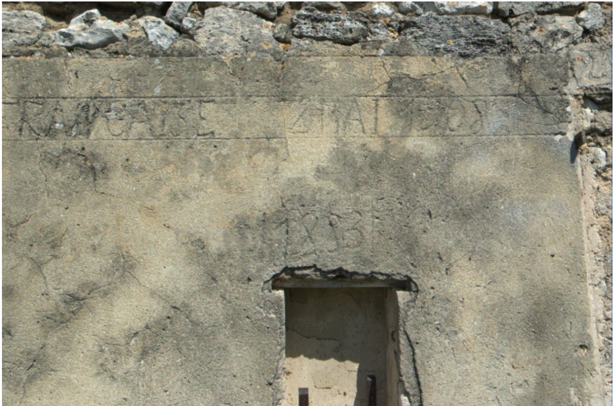
Le Fraysse. Détail d'inscriptions et dates gravées dans l'enduit servant de panneau d'informations municipales.
