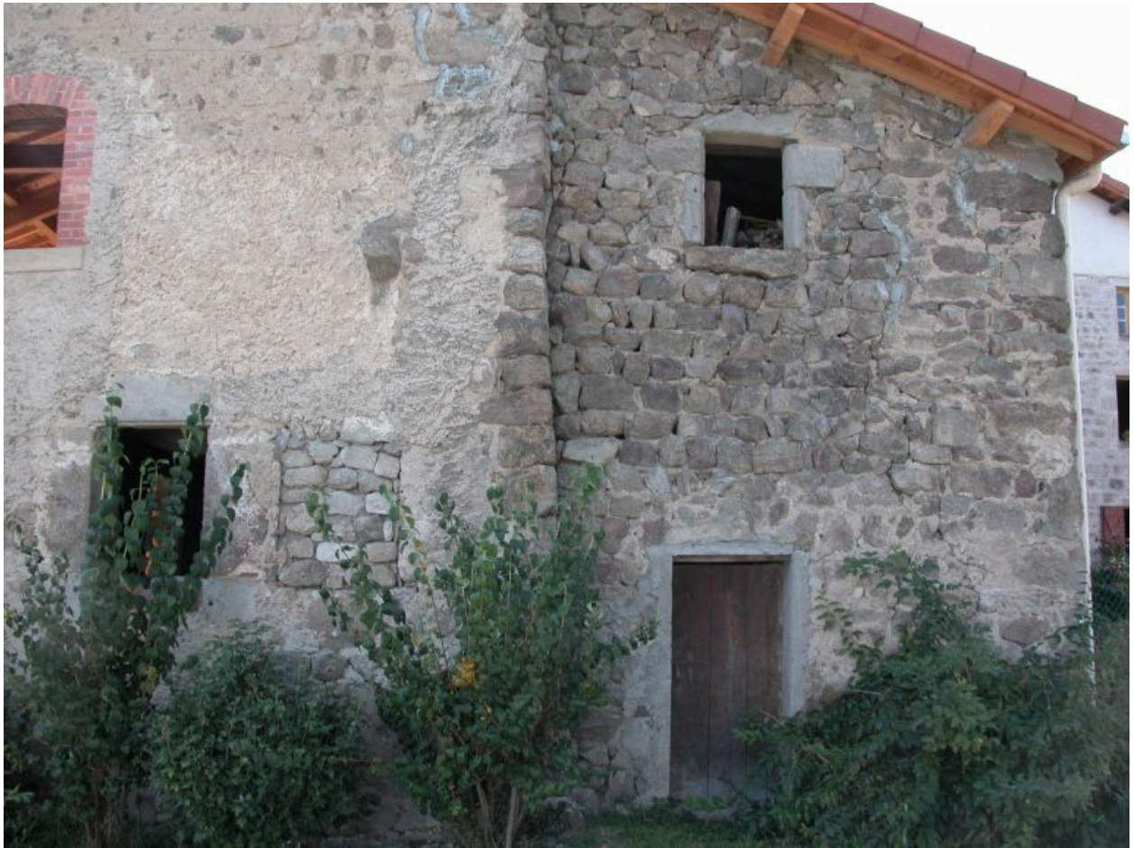
Vue du mur pignon et du mur de la cave du logis 4, depuis l'est (état en 2011).
