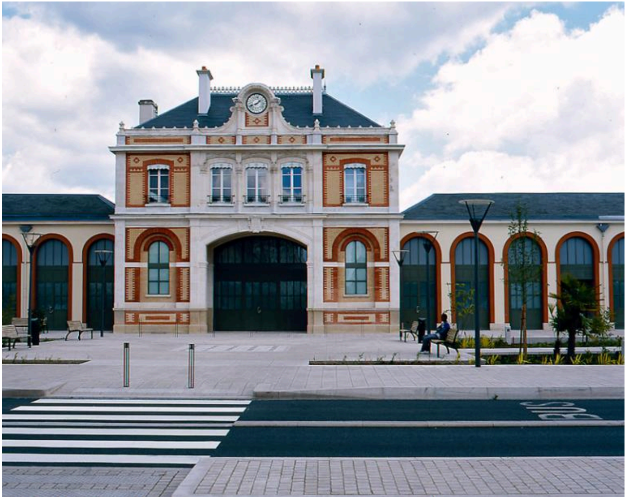
Le pavillon central et l'entrée des voyageurs depuis la place de la Gare.
