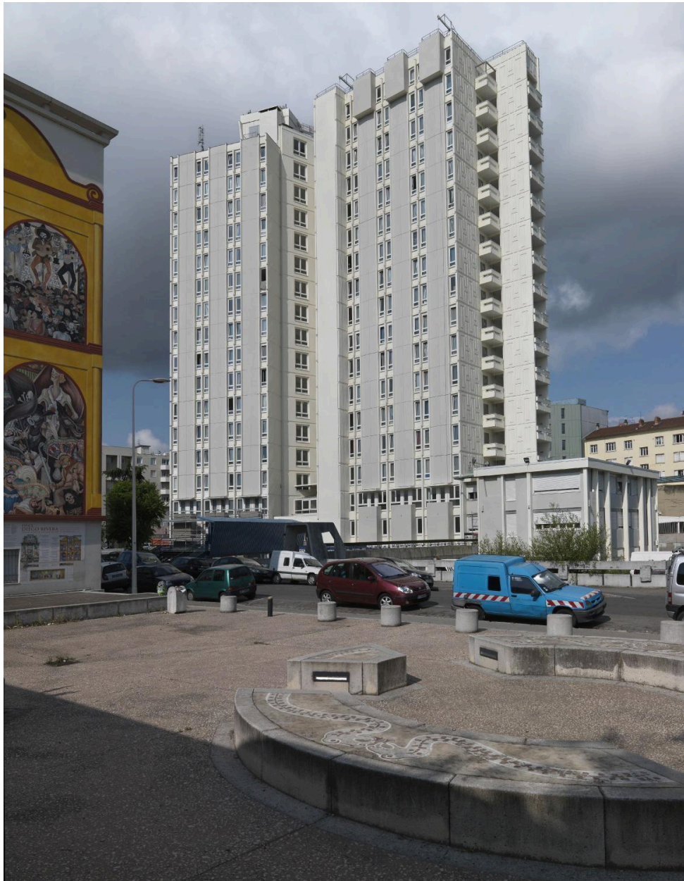
vue d'ensemble nord-est de la tour Sonacotra
