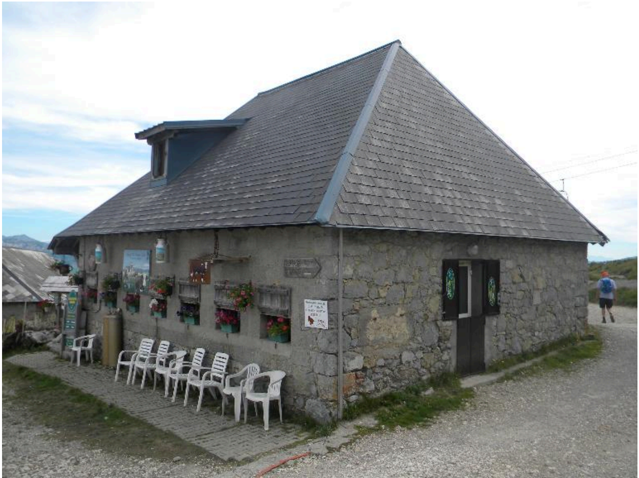
Vue du bâtiment principale avec les ouvertures réaménagées du freidi.
