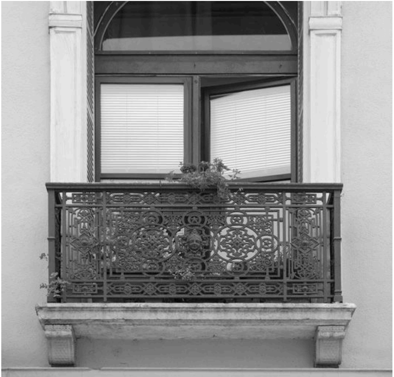
Elévation quai Saint-Antoine : 1er étage carré, détail d'un garde-corps
