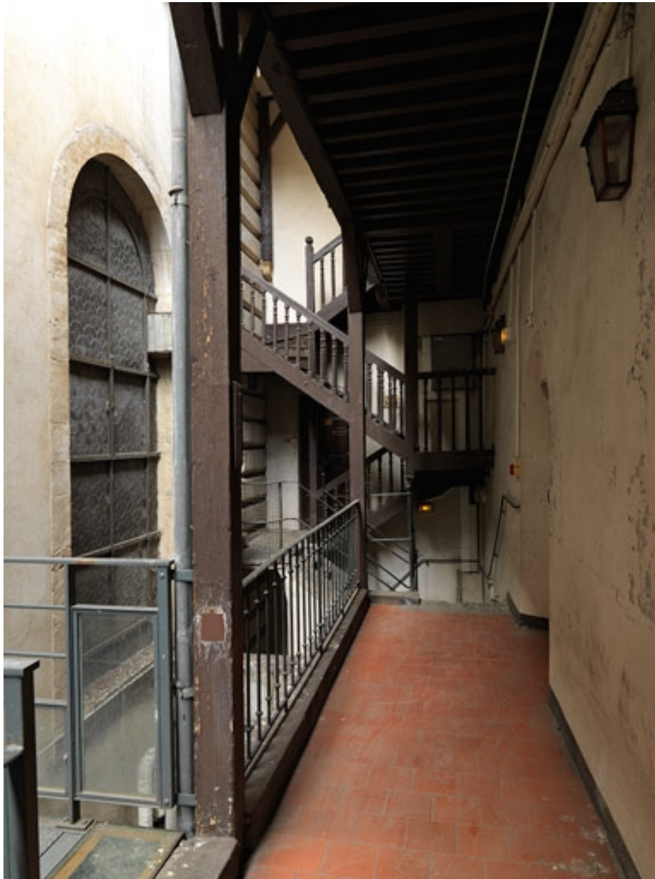
Bâtiment R. La galerie distribuant le 1er étage
