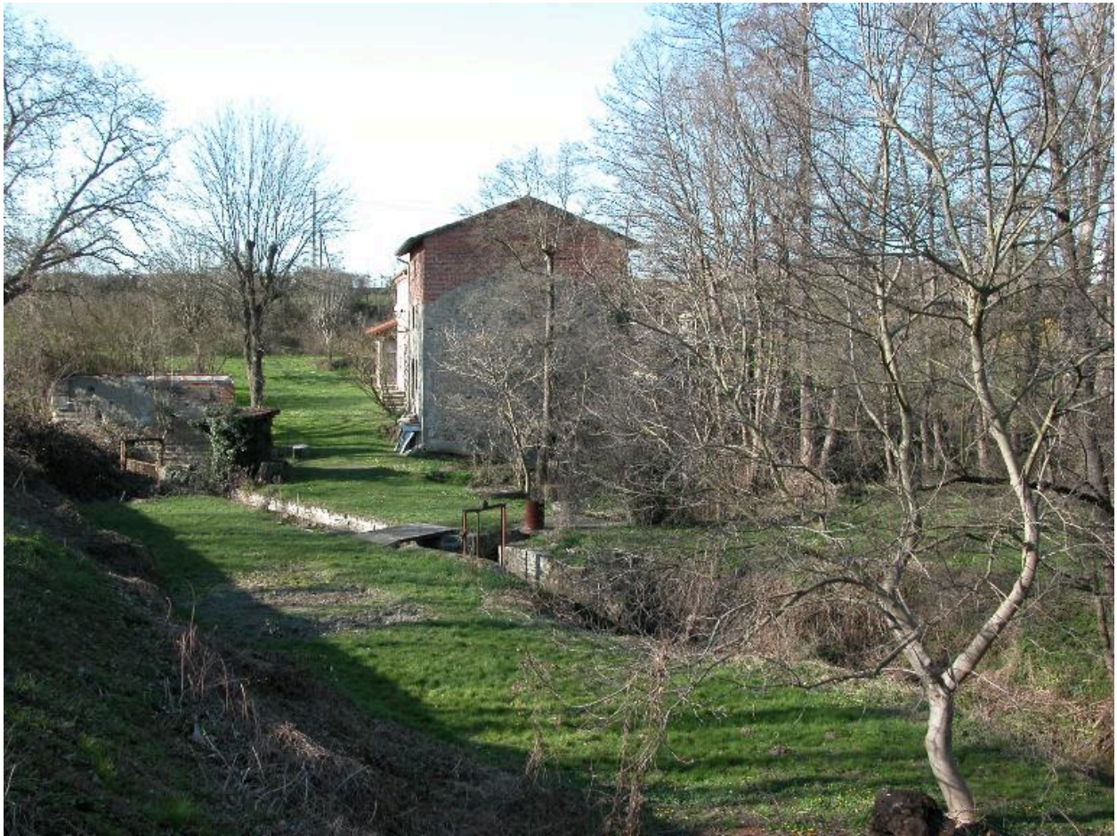
Vue d'ensemble du site du Moulin.
