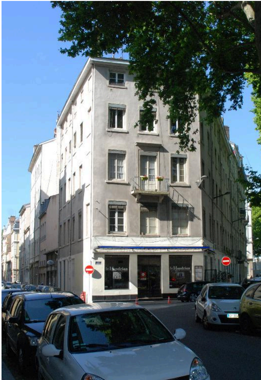
Vue d'ensemble, façade nord en angle sur la place Raspail
