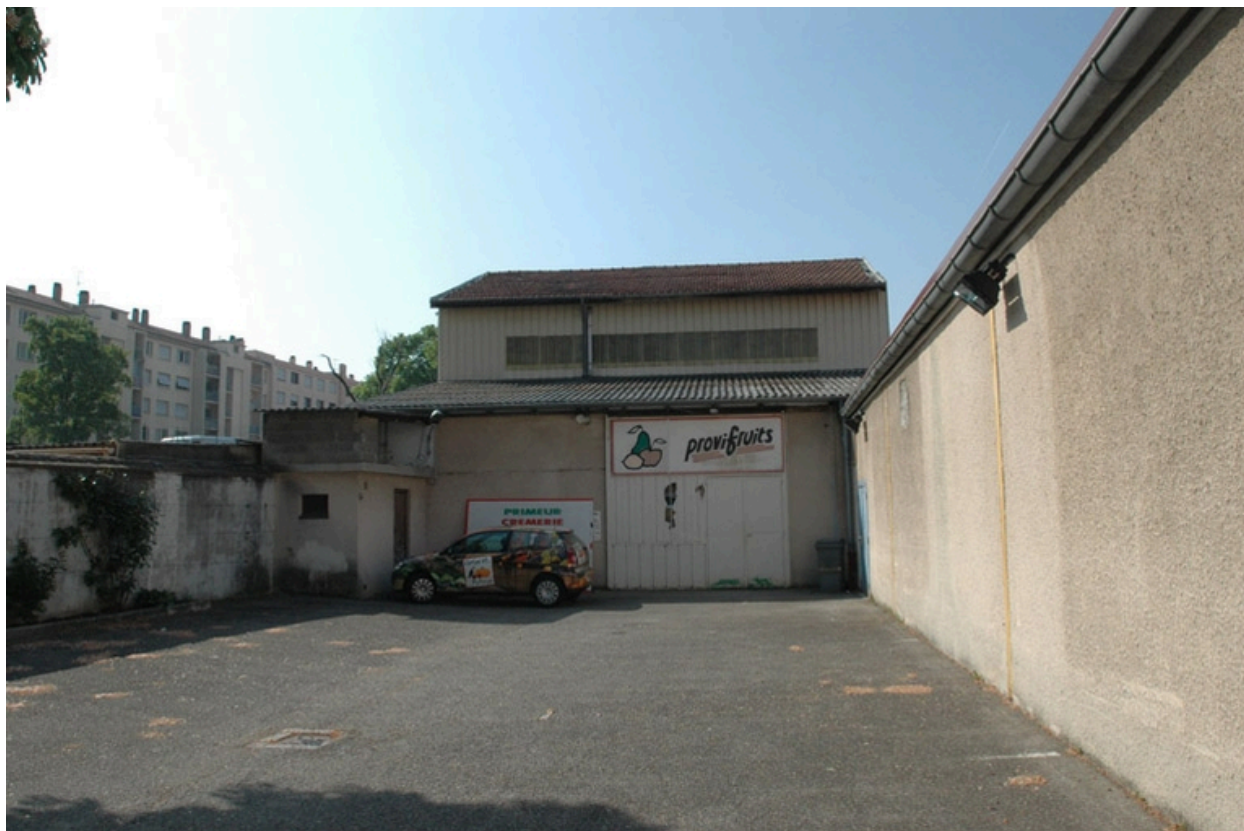
Atelier, vue nord.
