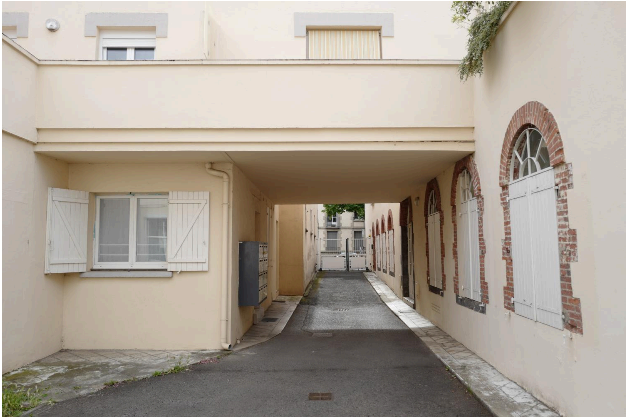
Elévation postérieure et allée du 17 bis avenue d'Italie
