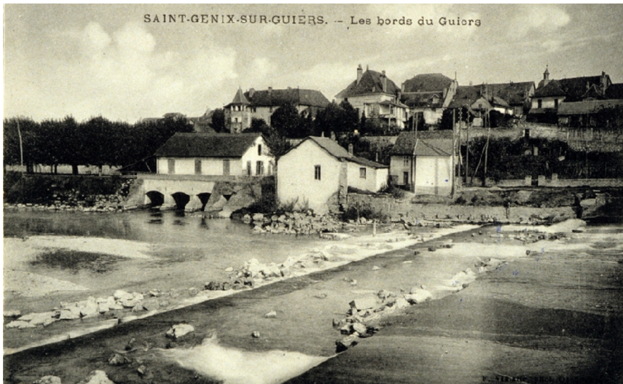
Centrale hydroélectrique, début du 20e siècle
