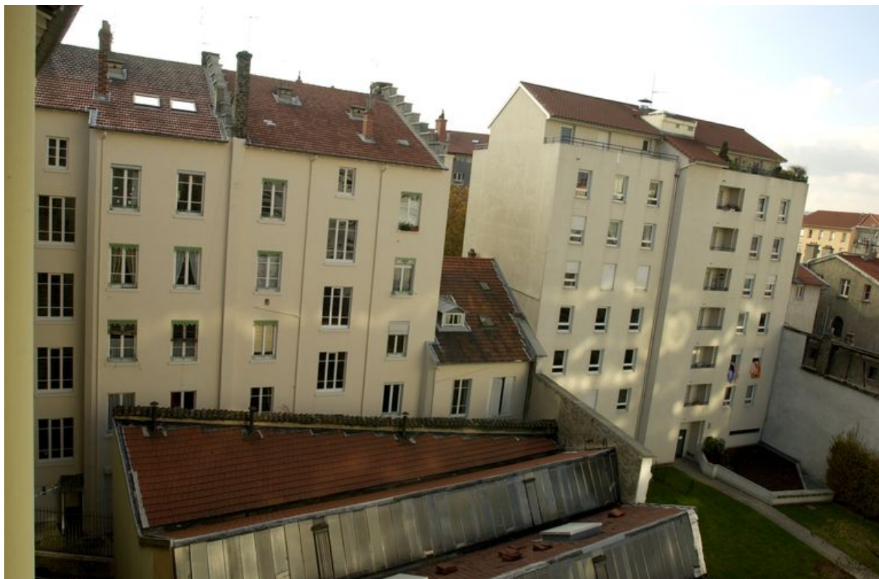
Elévation postérieure depuis le nord-est
