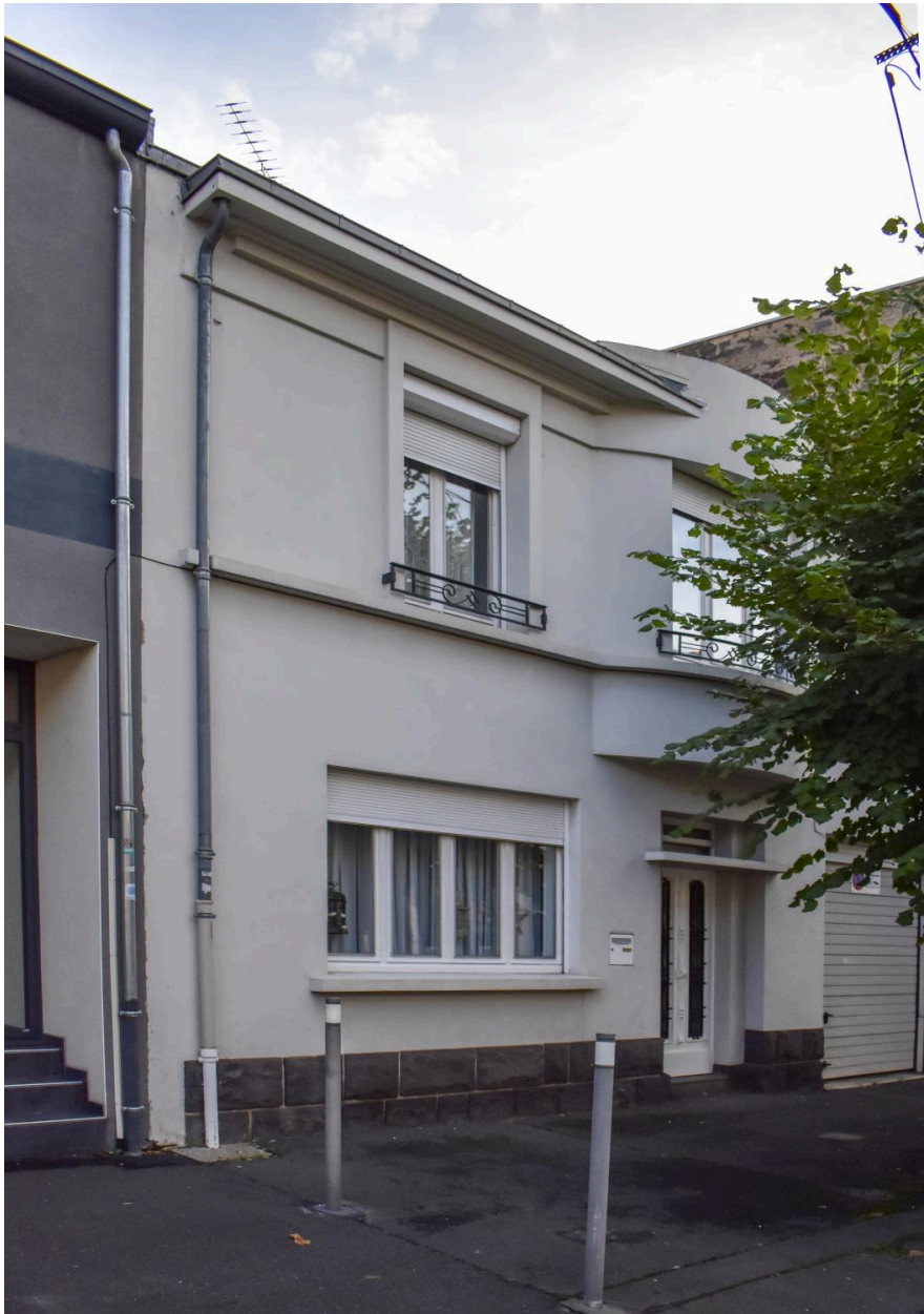
Façade sur le boulevard Jean-Jaurès
