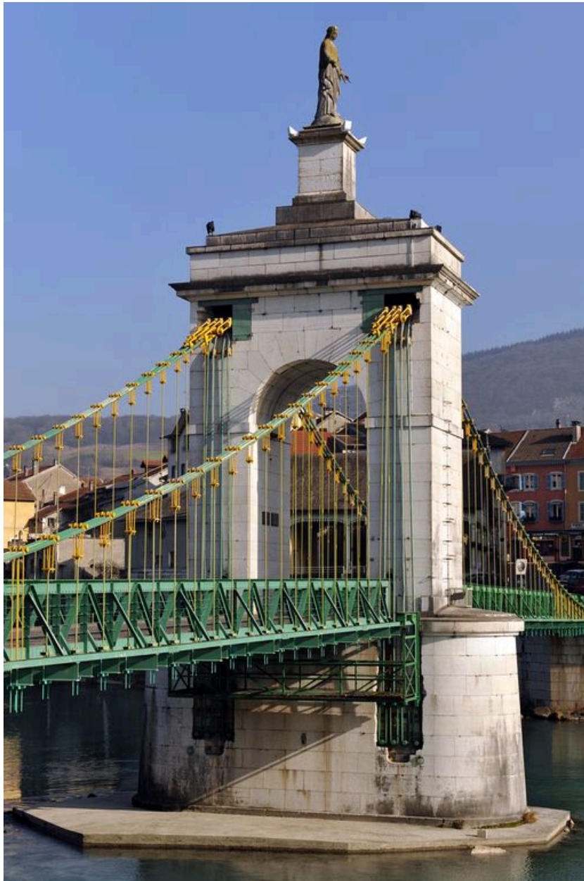
Vue partielle, pile centrale, de côté, face aval (depuis la rive droite)
