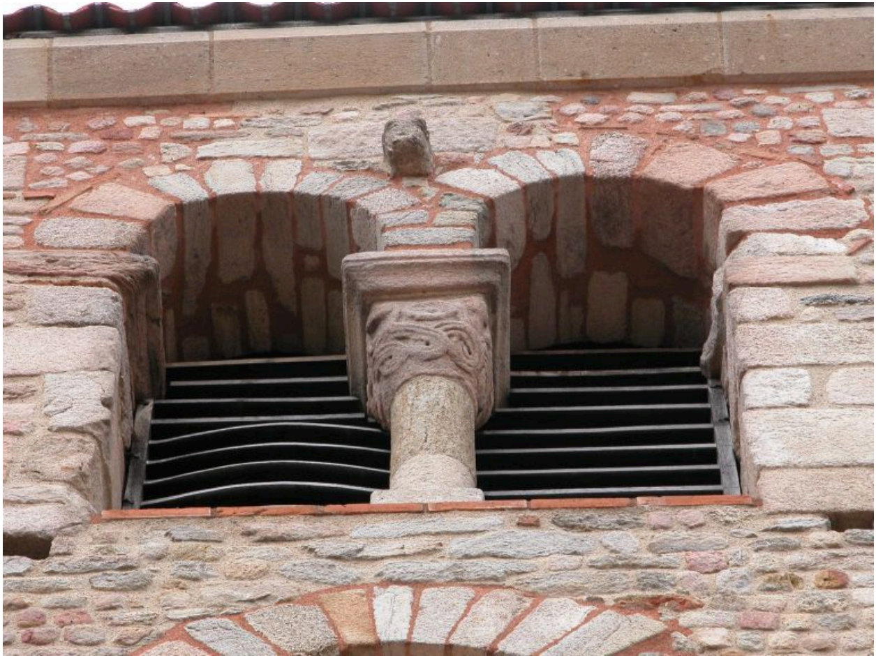
Détail de baies jumelées du clocher, face sud.
