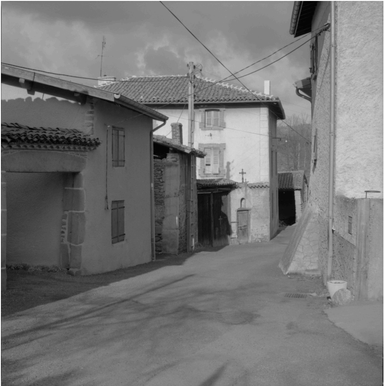
Vue d'une ferme du hameau de Chorigneux.
