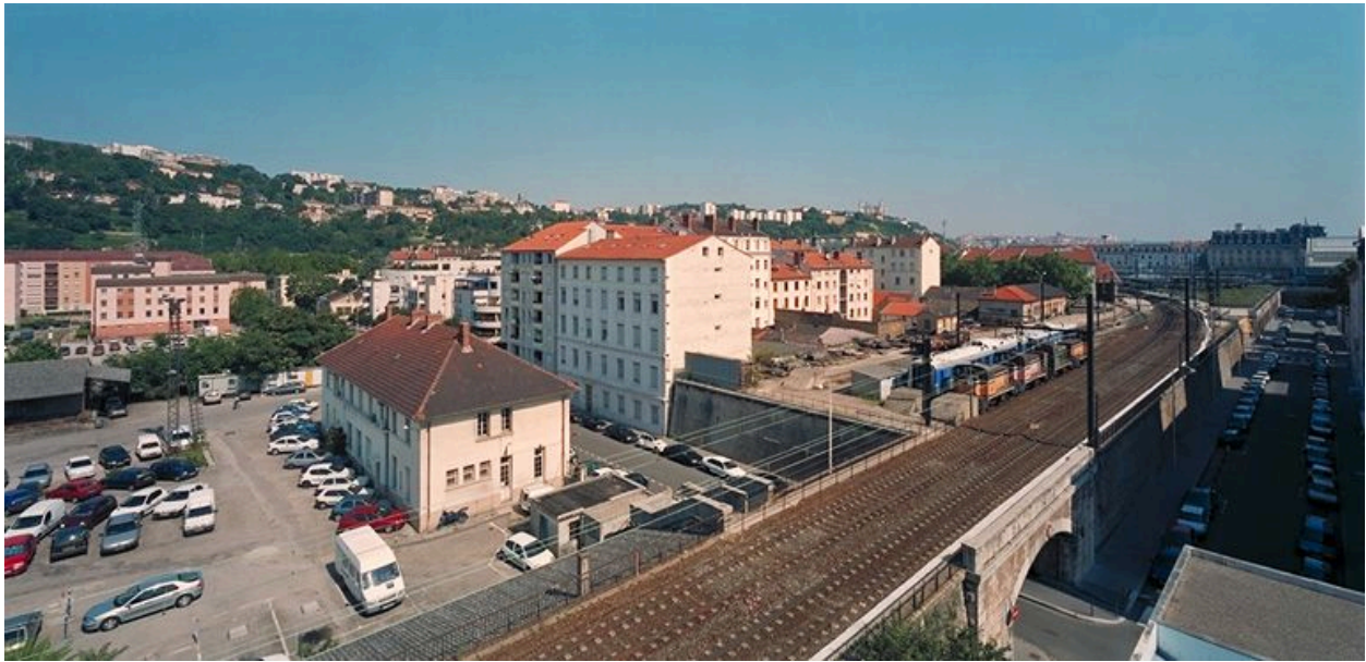
Vue de la voie ferrée au-dessus de la rue Bichat depuis le toit du collège Jean-Monnet
