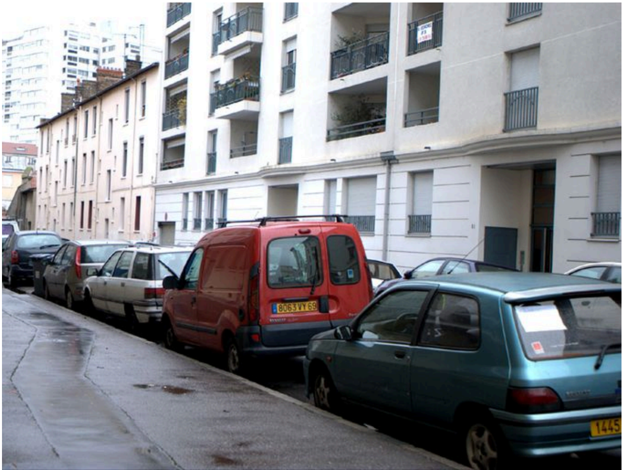
Détail du rez-de-chaussée
