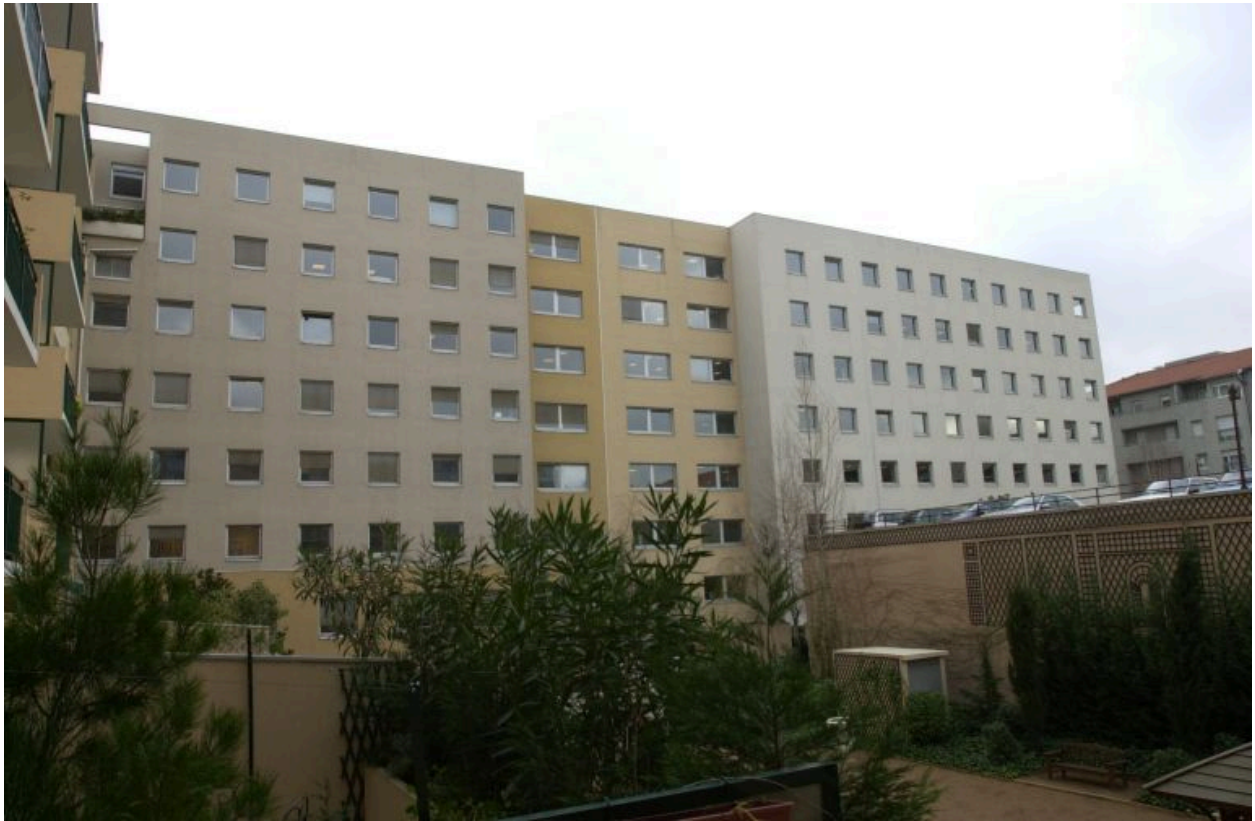
Elévation postérieure depuis l'escalier du 21 cours Charlemagne
