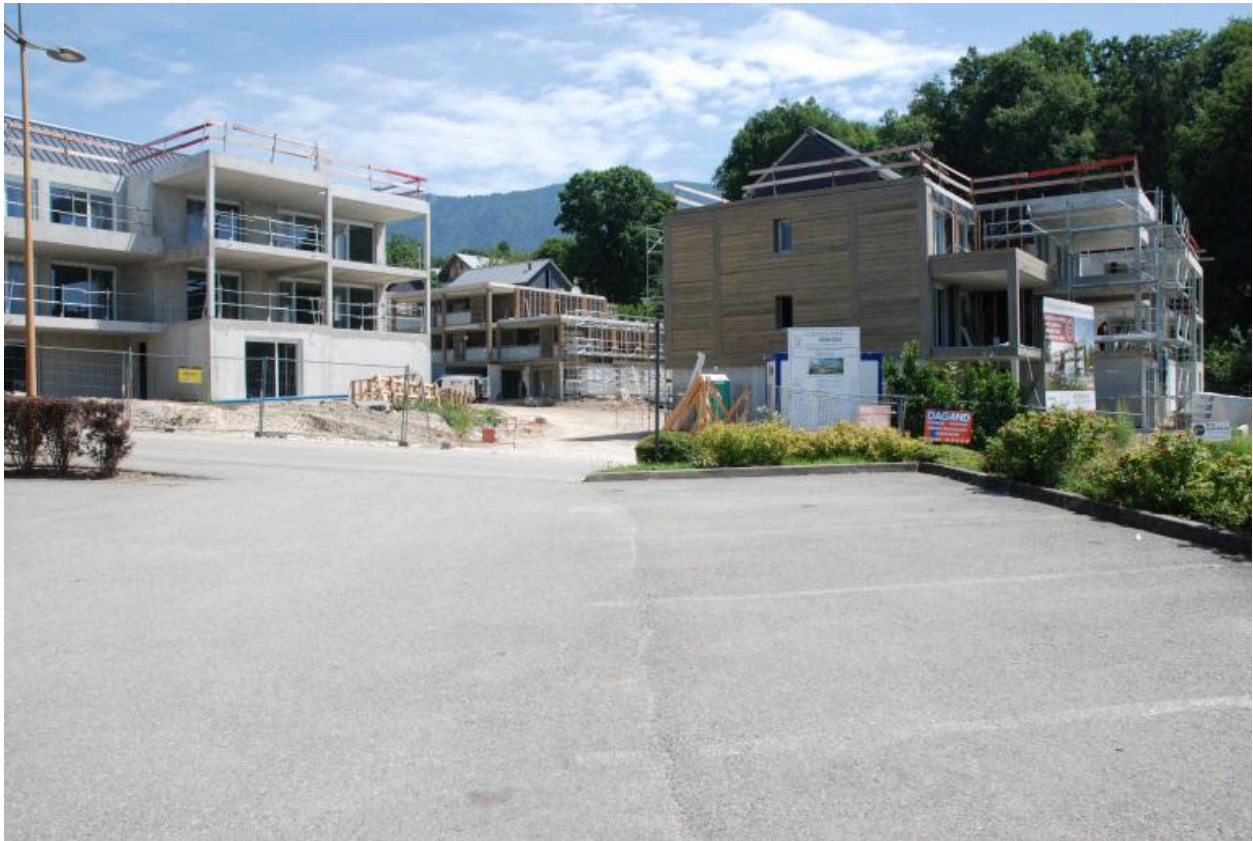
Vue des immeubles d'habitation collective en cours de construction en 2017 (2017 B4 138, 364, 576 à 578, 592, 593).
