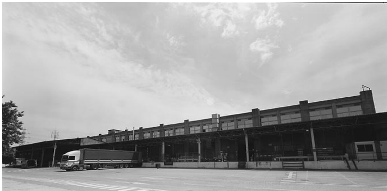
Vue est quais de livraisons
