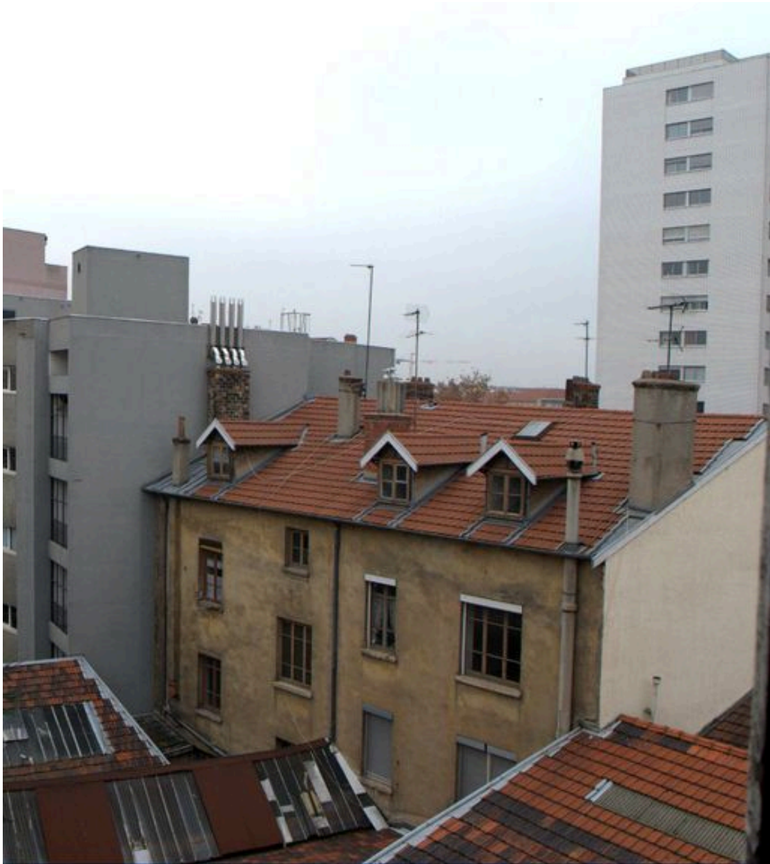
Élévation postérieure depuis le nord-est
