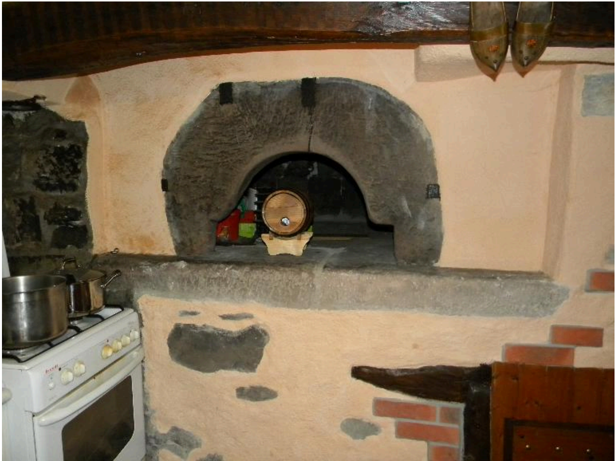
Vue de la bouche du four à pain dans l'actuelle cuisine.
