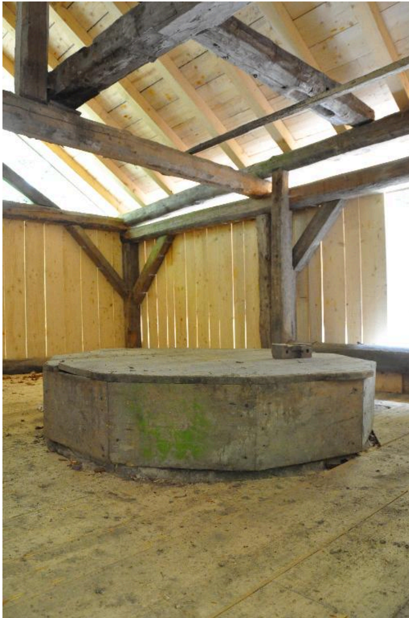
Vue intérieure du moulin après restauration, 2015.
