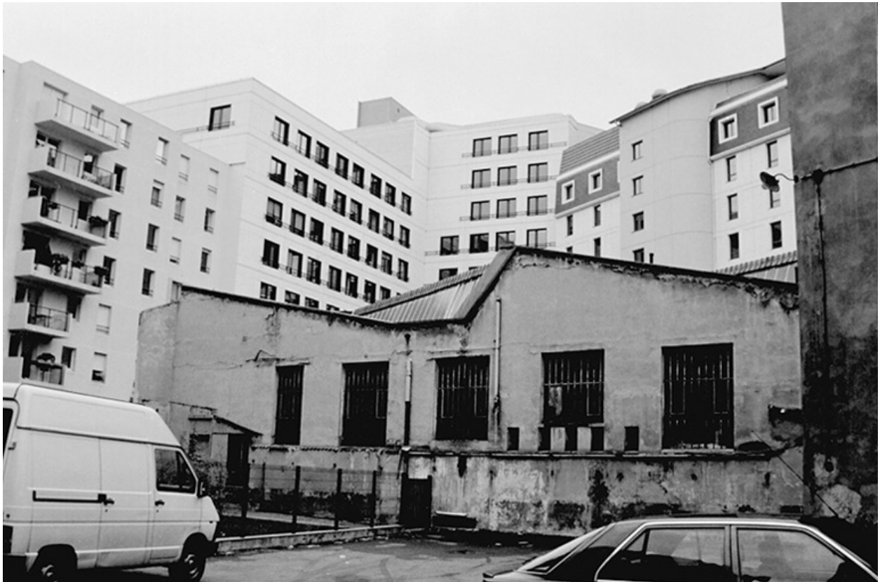
Vue d'ensemble avant réhabilitation
