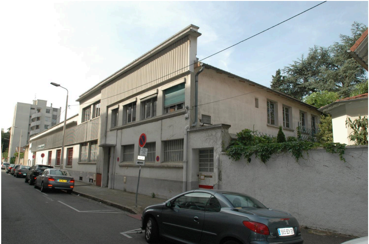
Vue du pignon latéral (parcelle 44)
