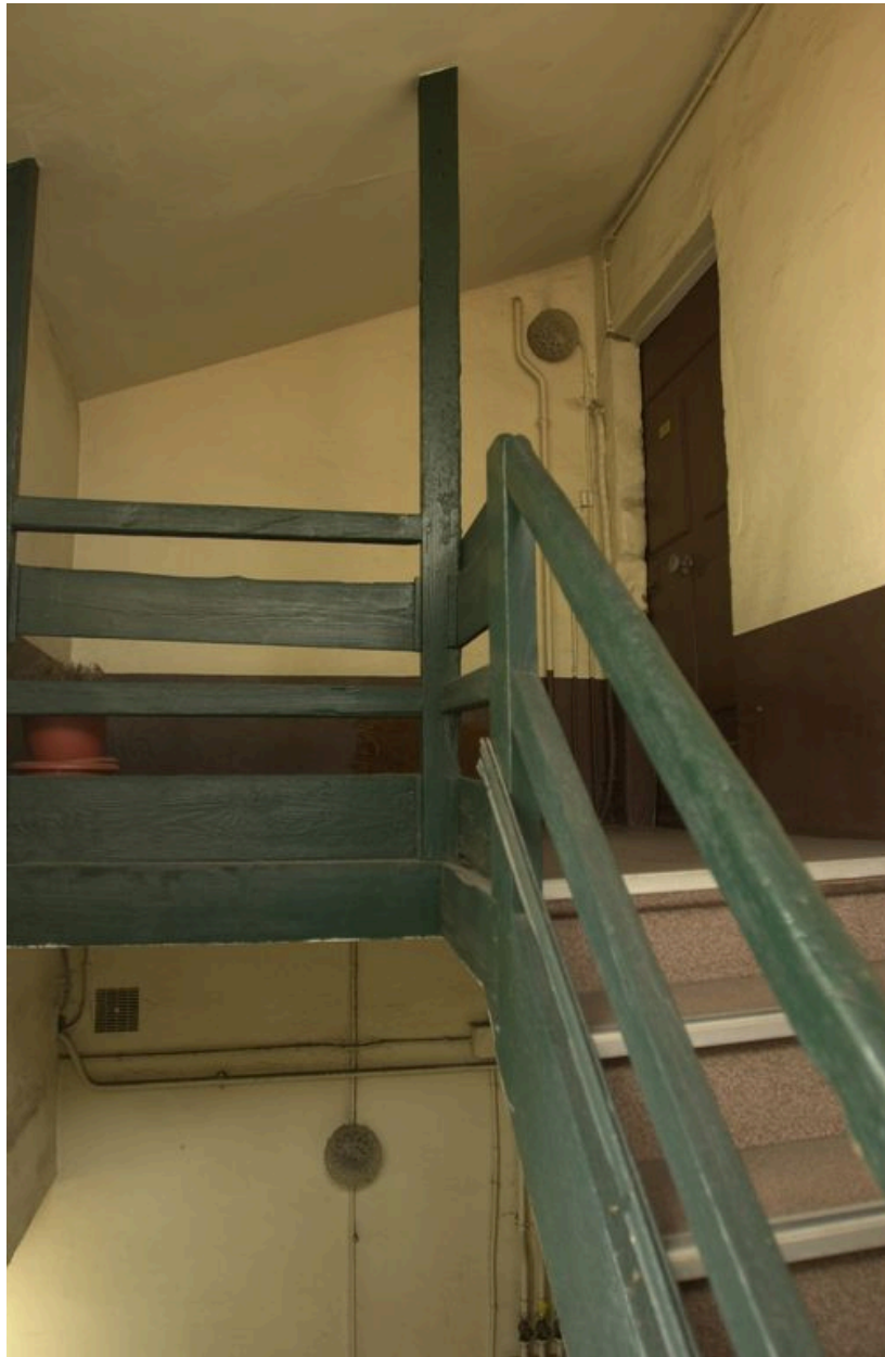
Dernier palier de l'escalier au niveau du comble
