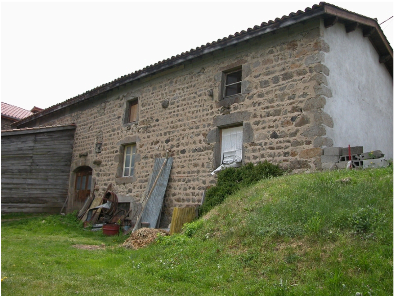
Vue d'ensemble de la façade arrière.
