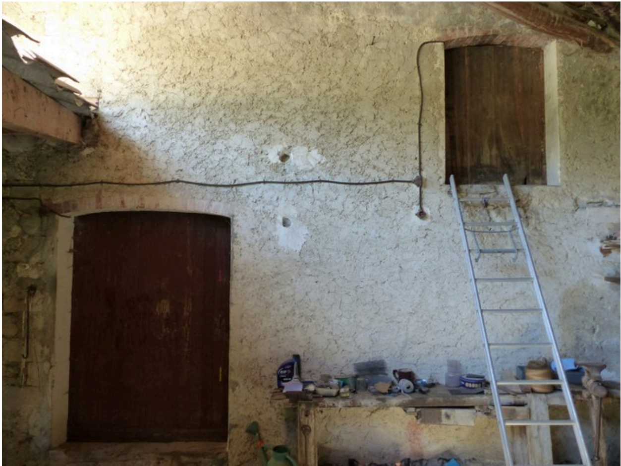
Pignon nord, porte de l'étable nord et baie fenière.
