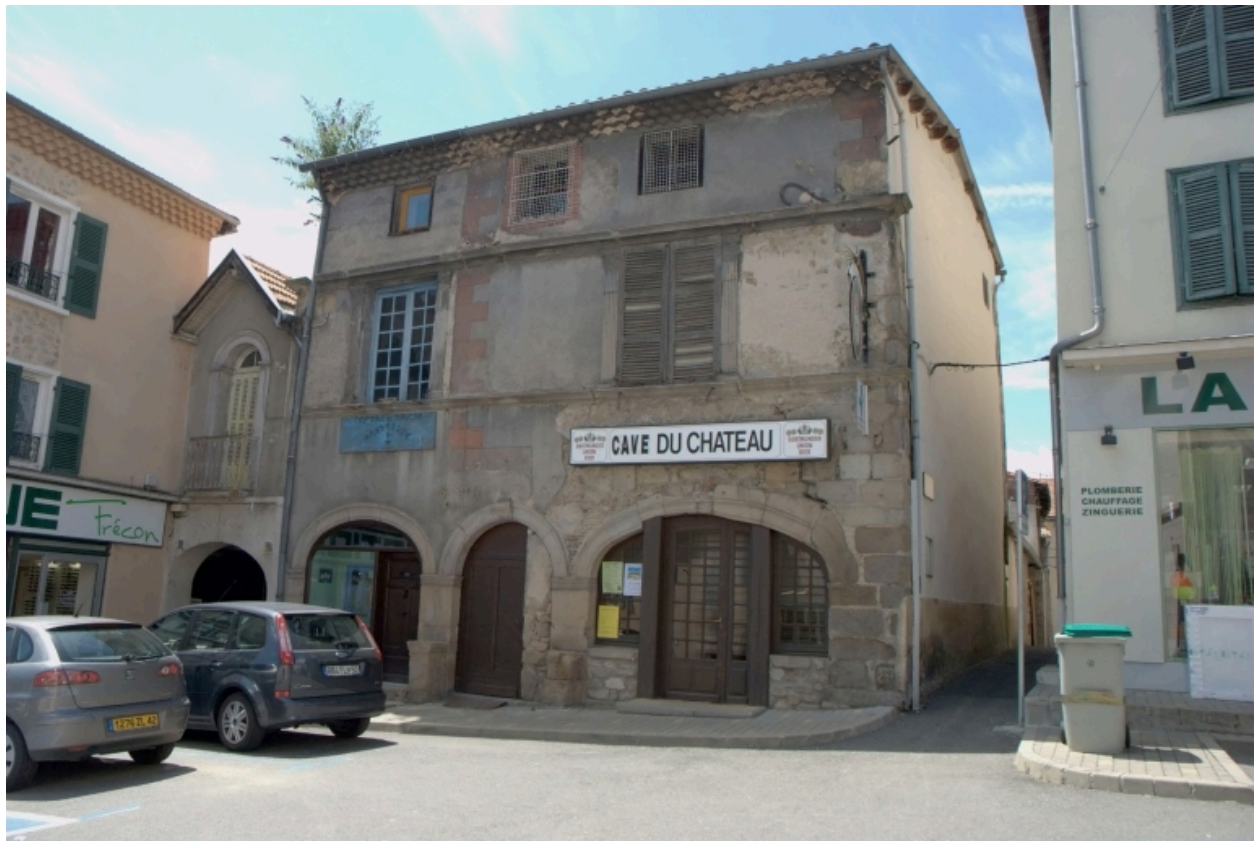
Îlot 6. République (place de la) 08, 10 / Vingtains (rue des). Vue générale des façades sur la place et sur la rue.
