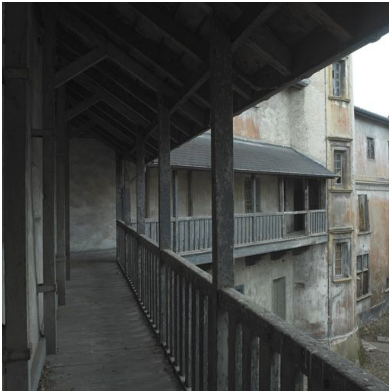
Coursière reliant la tour d'escalier à la tour sud-est depuis le sud-est
