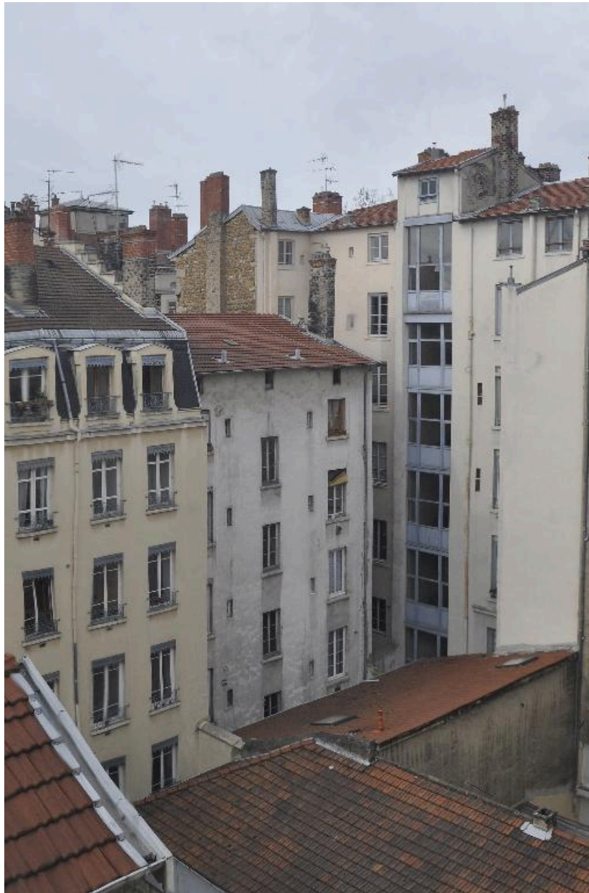
Elévation sur cour, vue générale
