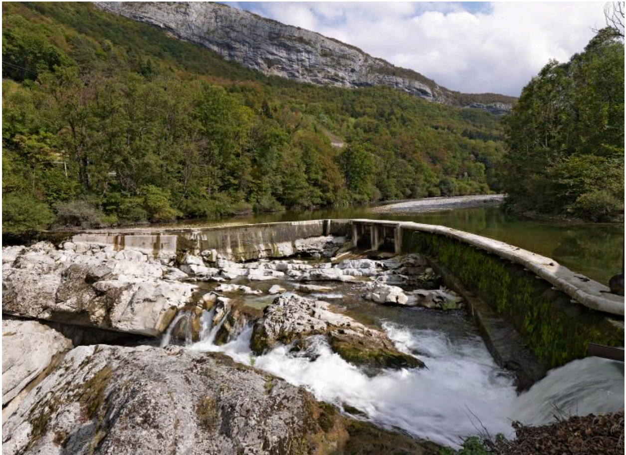
Vue générale du barrage sur les eaux du Chéran de la scierie Dagand.
