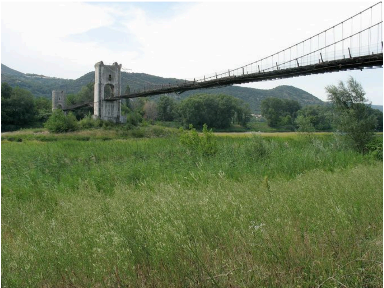
Vue du côté aval (depuis la rive gauche)
