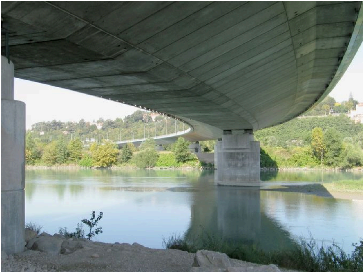
Vue partielle, de dessous, face amont (depuis la rive gauche)
