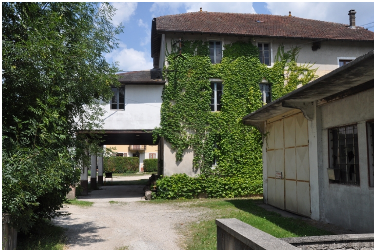
Vue générale du moulin, façade sud-ouest
