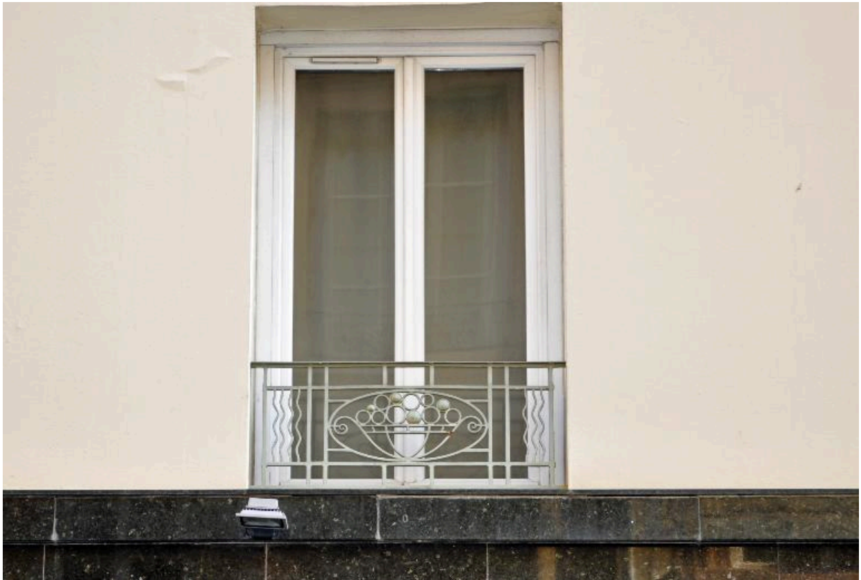
Détail d'une fenêtre, garde-corps en ferronnerie
