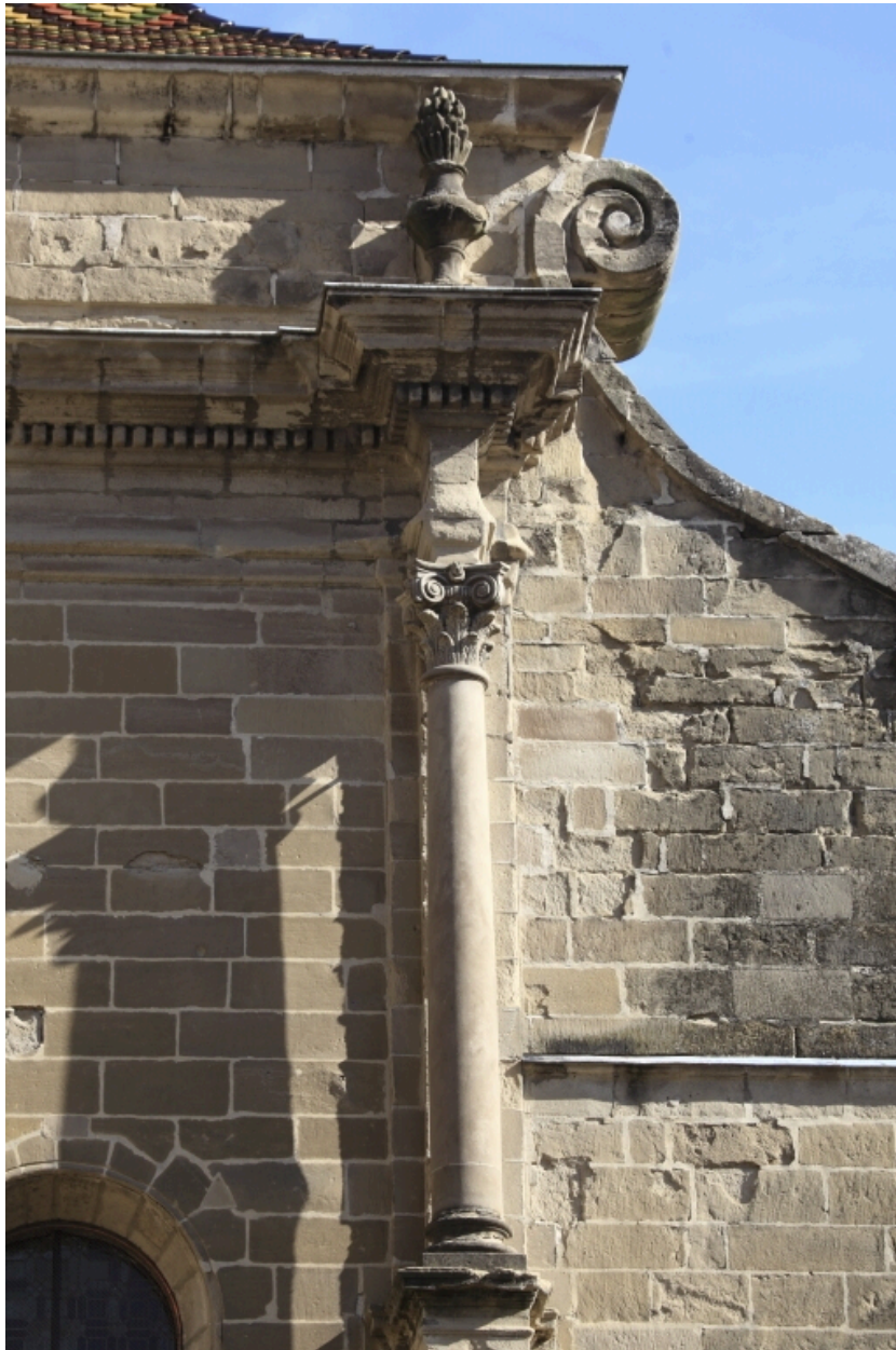
Façade. Détail. Colonne.
