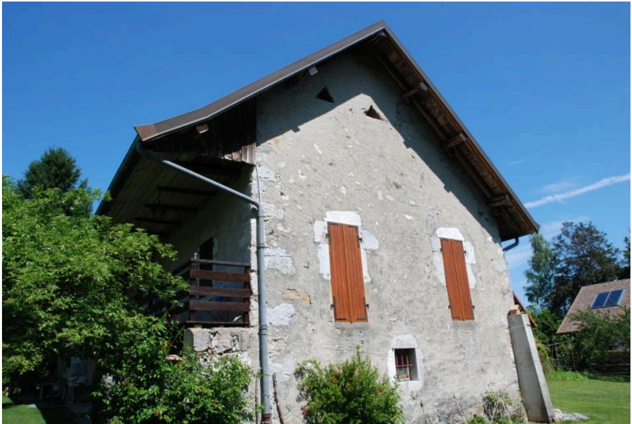
Vue du mur pignon sud.
